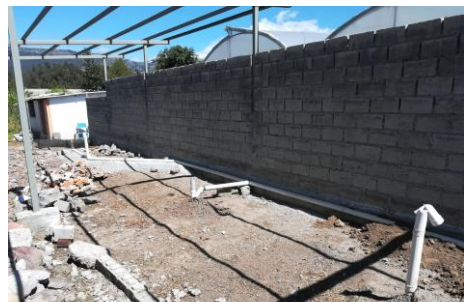
Hier werden die Schulküche und daneben die WCs entstehen
